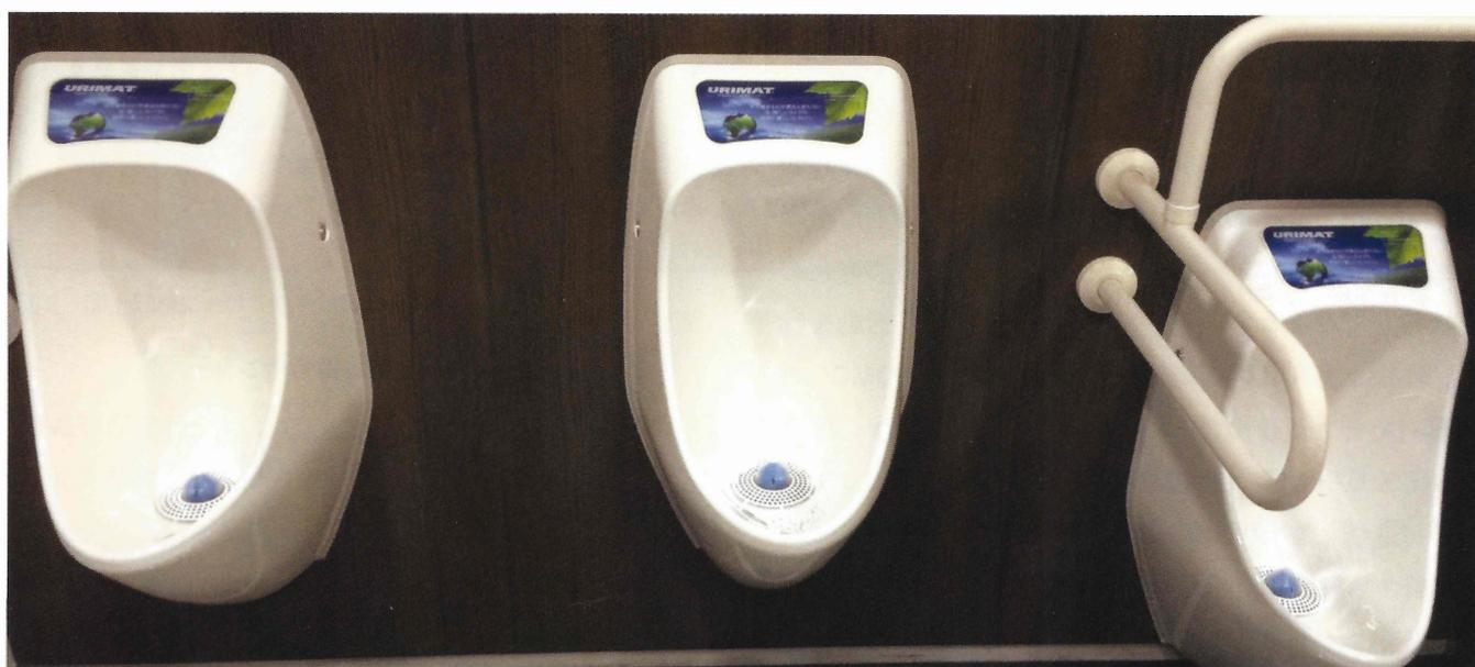
URIMAT Japan 株式会社が入力販売するエコトイレ「ウリマット」は、ほとんど水を使わないスイス発の男性用小便器。平時はもちろん、災害が起きた際の断水時や停電時でも日常通り使える。同社の試算によると、1台あたり50人(1人1日4回)が使う場合、日本国内で普及している1回の洗浄水量4リットルの小便器と比較して、水道代やクリーナー費用など金額にして年間約9万円(7割相当)安くなるという。上水道管やセンサーの工事が不要なので、施工費用も節約できる。同社によると、当初は水を使わない洗浄方法に抵抗を持つ企業も多かったが、ヨーロッパでの普及実績や環境意識の高まりから、試験設置を経て本格導入する事例が増えてきている。
