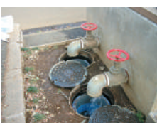
井戸(貯水槽排出口)
