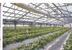
温室・植物工場
